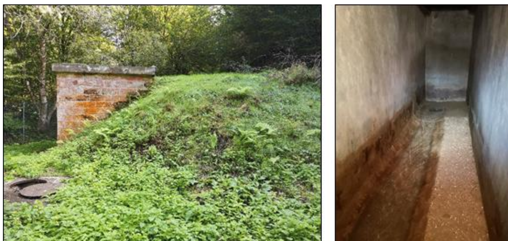
Figure 5 : Photographie de la source Drachenbrunnen et de la station de captage
