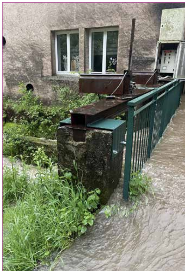
Le barrage de l'ancienne usine
