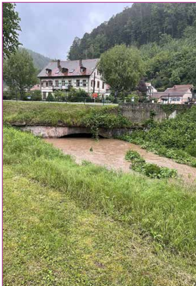
Le débouché du Trimbach, 17 mai 2024
