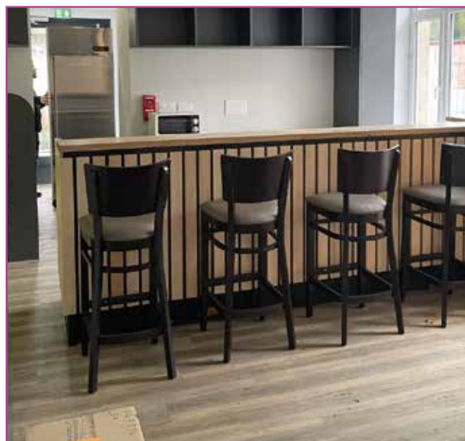
Photos de l'intérieur du restaurant « Chez Elise » en cours d'aménagement.
